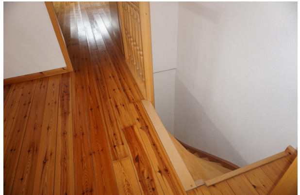
Treppe zum Spitzboden
